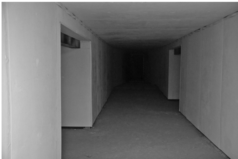
Рис. 2. Общий вид шахты № 2 ИМЗ СО РАН, реконструированной для размещения первой очереди Федерального криохранилища семян растений.
